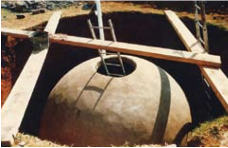
'n Misverteerder tydens installasie. Let op die koepelvormige dak vir doeltreffende gasopvanging
